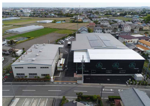
大井川茶園本社工場全景
